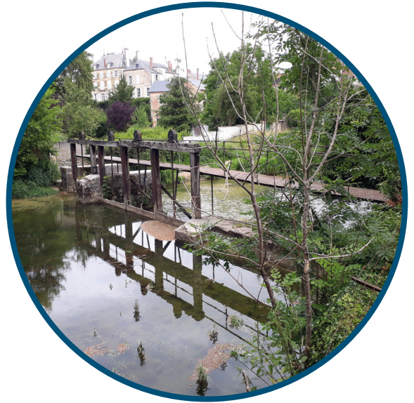
L'ouvrage de la Perception avant travaux
