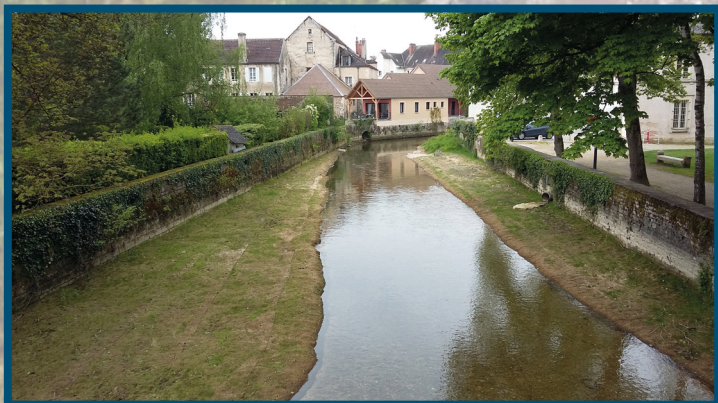
Création de banquettes sur la Seine à Châtillon-sur-Seine (action réalisée en 2016)
