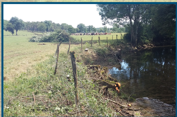
Travaux d'entretien de la ripisylve
