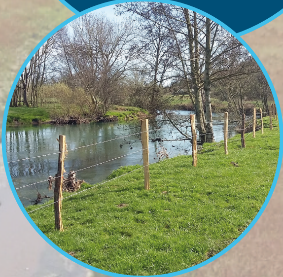
Pose de clôtures le long de la Seine à Vix (action réalisée en 2017)
