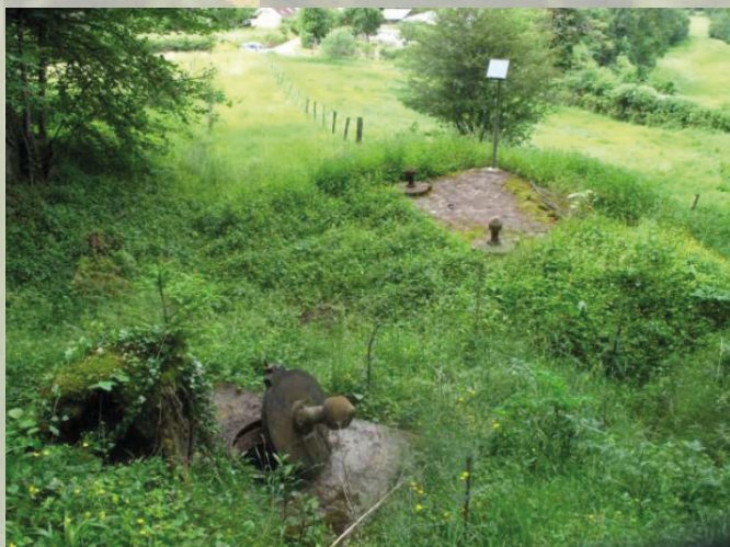
Captage de la source de la Douhie
