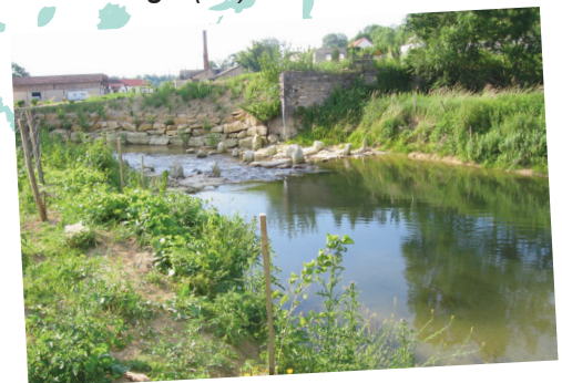
Effacement de l'ouvrage de la Granitière à Châtillon-sur-Seine (21)
