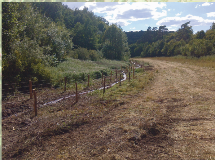
Remise au point bas du ruisseau de la combe Vellerot à Rochefort-sur-Brevon
