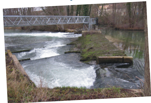
Passe à poissons à Gomméville (21)
