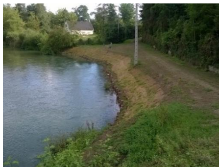
Photo après travaux
