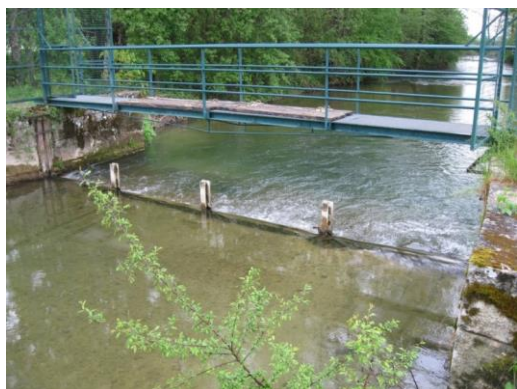
Site avant travaux
