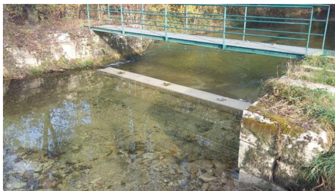
Site lors de la réception du chantier
