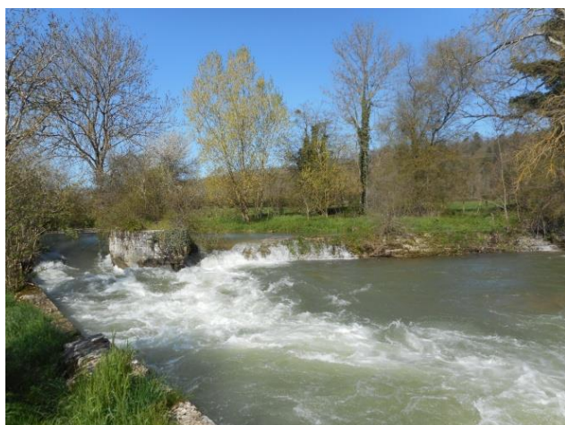
Site avant travaux
