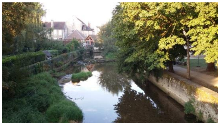
Site avant travaux
