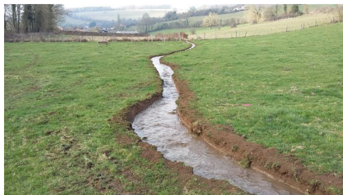
ruisseau après travaux
