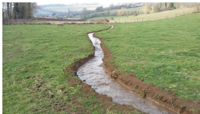
ruisseau après travaux
