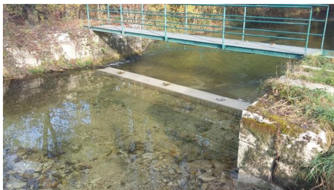
Site lors de la réception du chantier
