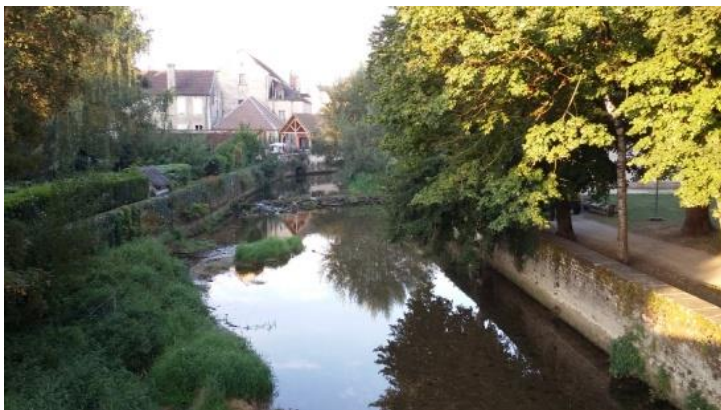
Site avant travaux
