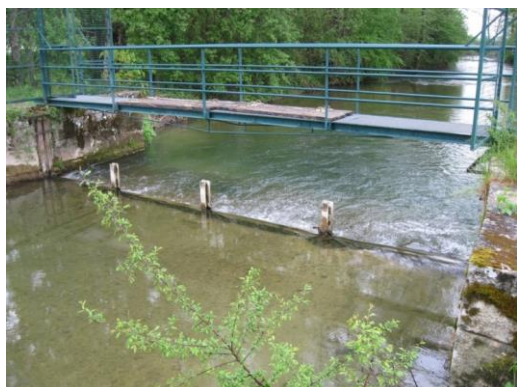
Site avant travaux
