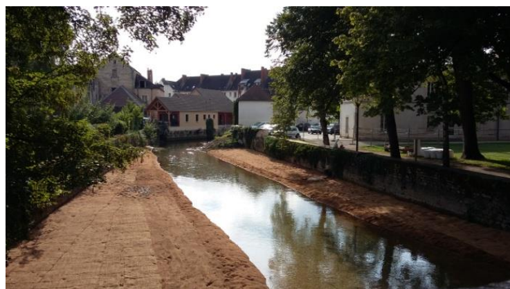
Site lors de la réception du chantier
