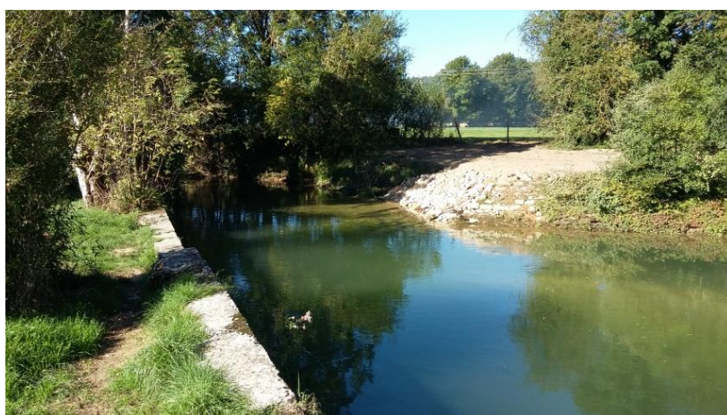
Site lors de la réception du chantier
