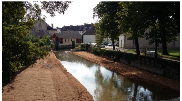
Site lors de la réception du chantier
