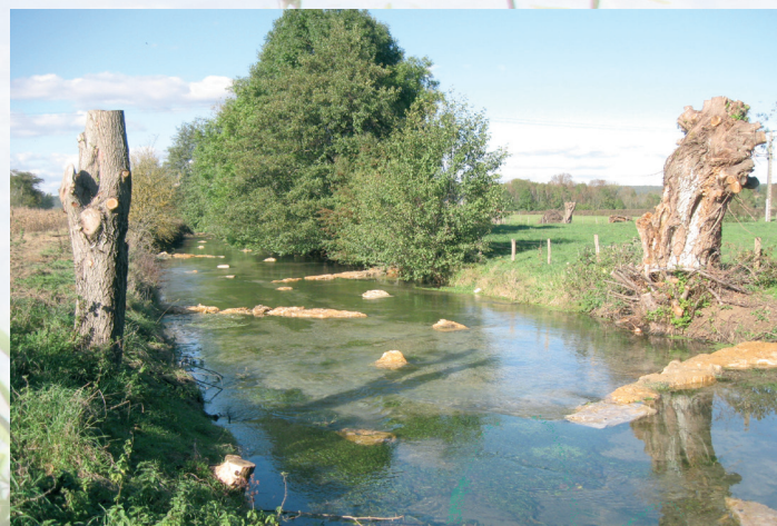
Création d'epis et de blocs-abris sur la Seine
