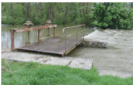
Ouvrage répartiteur amont
