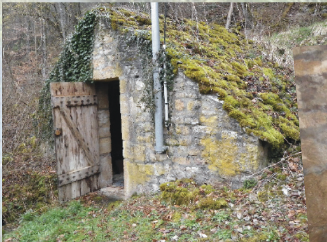
Captage du Puiset
