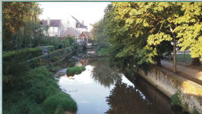
Le cours d'eau avant les travaux....
