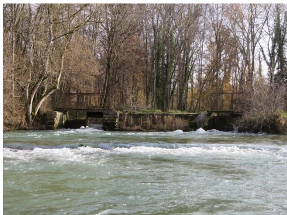
Vue depuis l'aval
