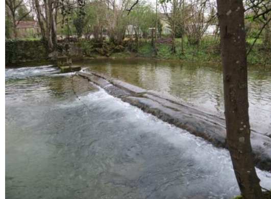
Vue depuis l'aval
