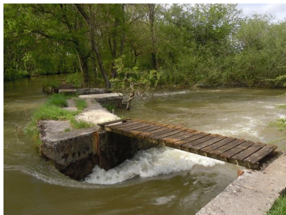
Vue depuis l'amont pendant une crue
