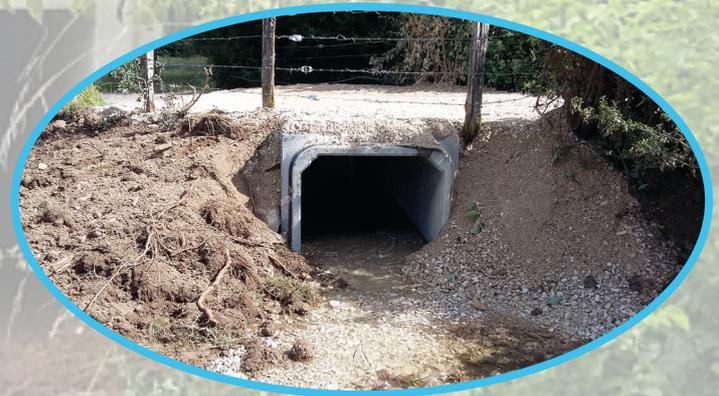
A l'inverse, un calage trop bas des passages busés provoque un engorgement permanent, des dépôts de sédiments, et rend l'ouvrage non fonctionnel même en basses eaux.
