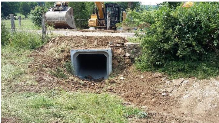
Deux passages busés ont été remplacés sur le Ruisseau de Villarnon et sur le ruisseau du Fays. Les deux passages routiers ont été réalisés en ponts cadres pour des contraintes de résistance. La couche de roulement a été refaite à l'identique.
