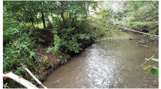
Digues constituées de matériaux terreux (photo avant travaux)
