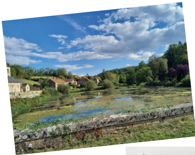
Le site avant et pendant les travaux
