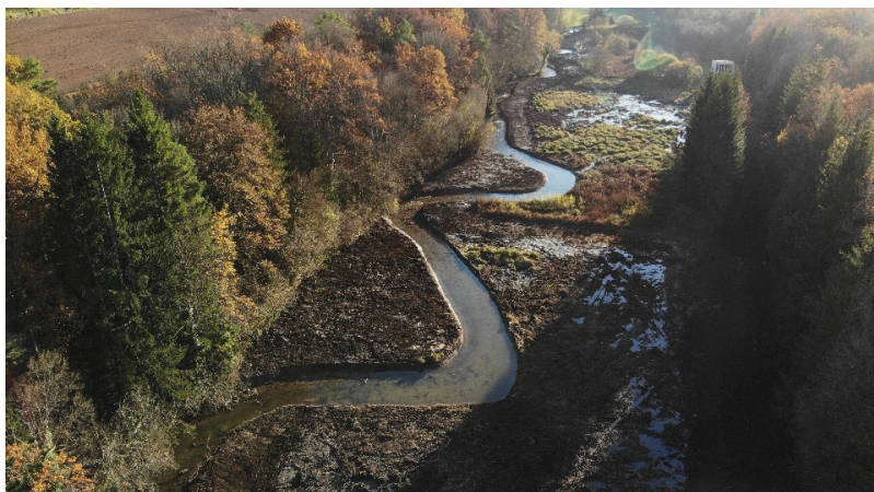
le site après travaux
