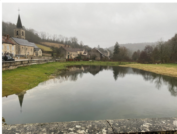
Le site après les travaux
