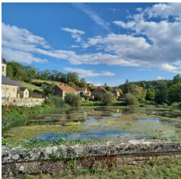
Photo avant travaux (septembre 2019)
