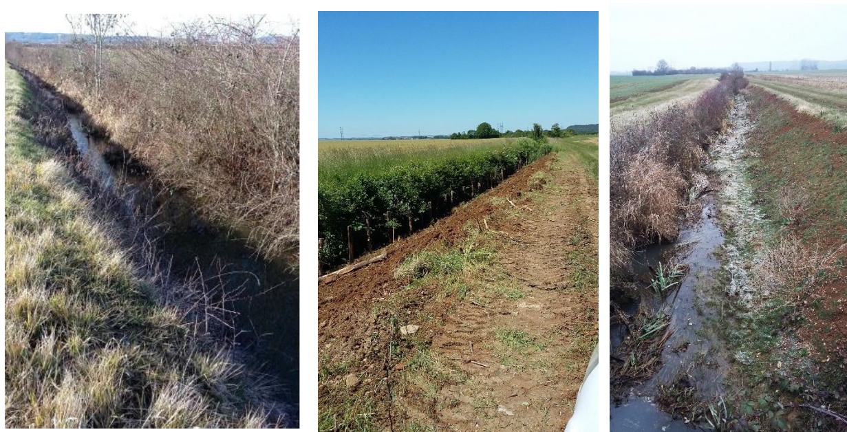
Figure 5 - de gauche à droite : état initial, pendant les travaux été 2021, hiver 2021
