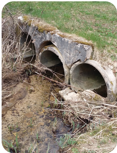
Passage busé sur l'Aubette
