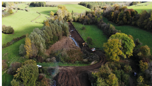
La zone humide pendant les travaux
