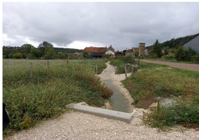
Figure 17 : photos après travaux de découverte du ruisseau de Cosne à Quemigny-sur-Seine
