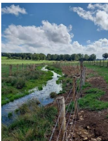
Figure 18 : photos avant après travaux de reprofilage et recharge sédimentaire de la Petite Laignes à Chaumelles-Baigneux
