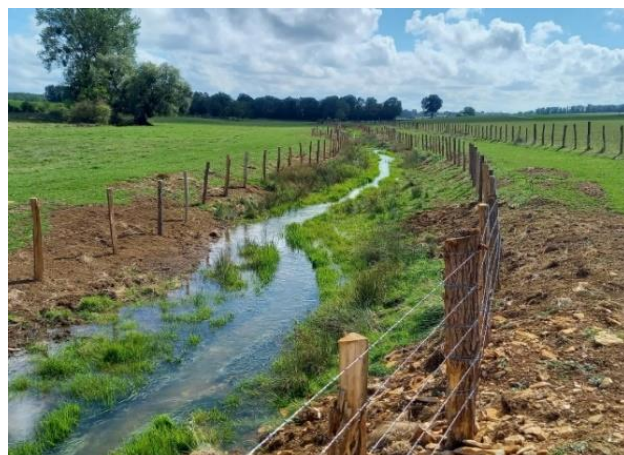
Figure 18 : photos avant après travaux de reprofilage et recharge sédimentaire de la Petite Laignes à Chaumelles-Baigneux
