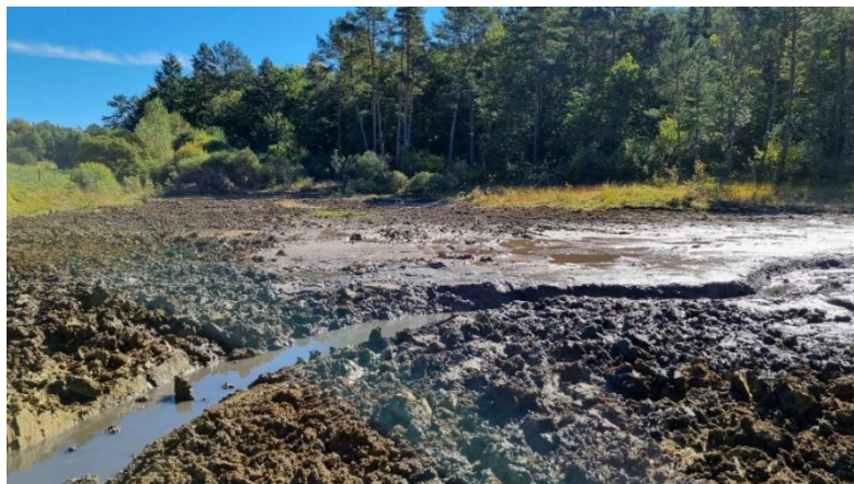
Figure 15 : photos avant, pendant et après travaux de l'effacement de l'étang Carillon à Villars-Santenoge
