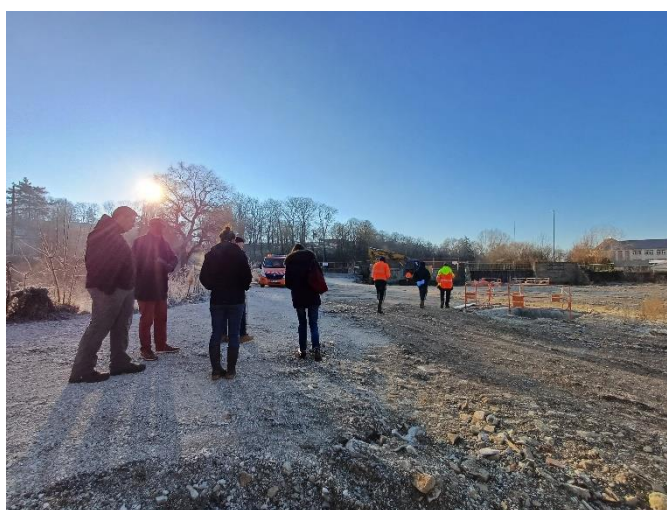
Figure 13 : Photographie prise lors de la réunion de lancement des travaux de démolition des infrastructures le 14 janvier 2025
