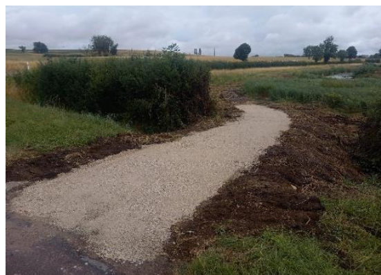
Figure 24 : photos avant et après travaux de restauration de la zone humide de Chaume-les-Baigneux
