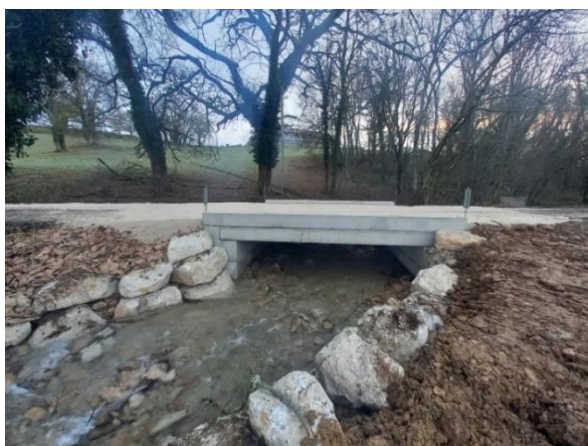
Figure 16 : photos avant et après travaux de rétablissement de la petite continuité sur le Revinson à Etalante
