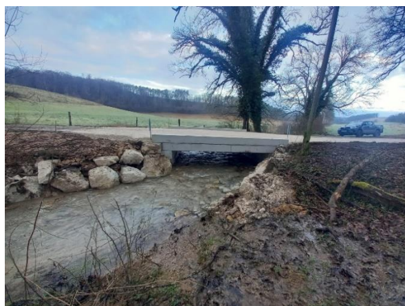
Figure 16 : photos avant et après travaux de rétablissement de la petite continuité sur le Revinson à Etalante
