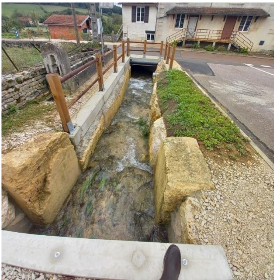
Figure 17 : photos après travaux de découverte du ruisseau de Cosne à Quemigny-sur-Seine
